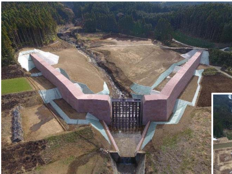
三王谷川1他28年災害関連緊急砂防(堰堤工)工事 他合併
